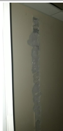
Prélèvement - P040 : R+1 / WC Femme - Enduit- (Absence d'amiante)
