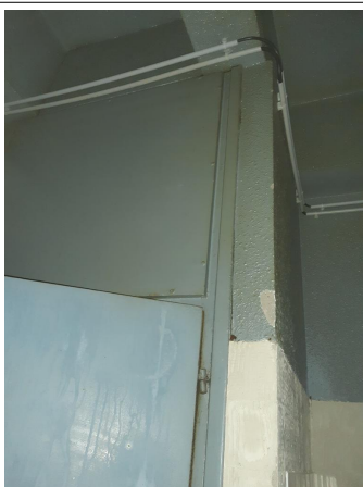
Prélèvement - P067 : R+1 / Zone Désaffectée / Espace distribution auto - Enduit- (Présence d'amiante)
