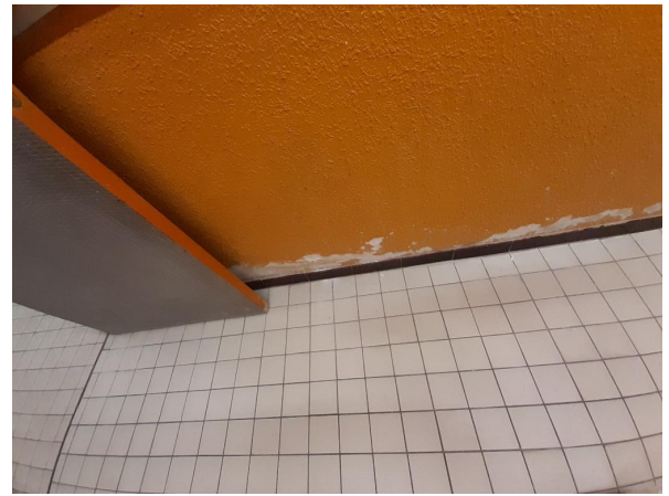
Prélèvement - P030 : R+1 / Zone cuisine / Bureau - Enduit- (Présence d'amiante)
