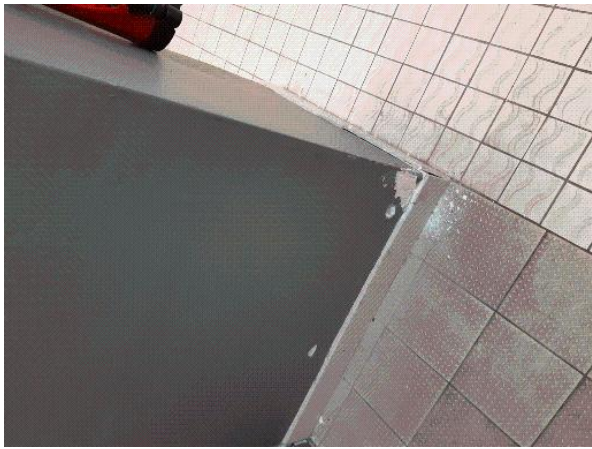
Prélèvement - P081 : R-1 / Dégagement - Enduit- (Absence d'amiante)
