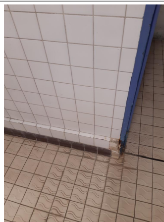
Prélèvement - P016 : R+1 / Zone cuisine / Laverie vaisselle et plonge - Colle- (Absence d'amiante)
