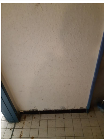
Prélèvement - P019 : R+1 / Zone cuisine / Laverie vaisselle et plonge - Enduit- (Présence d'amiante)
