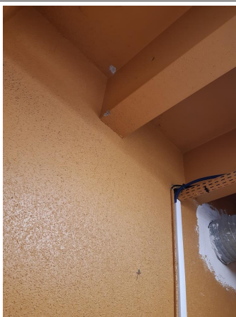
Prélèvement - P088 : R+1 / Zone cuisine / Bureau - Enduit- (Présence d'amiante)
