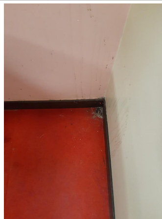
Prélèvement - P003 : R+1 / Zone Accueil et salle restaurant - Ragréage, Lé plastique avec sous-couche- (Absence d'amiante)
