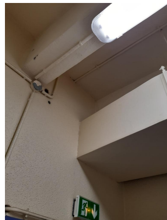
Prélèvement - P087 : R+1 / Zone cuisine / Laverie vaisselle et plonge - Enduit- (Présence d'amiante)
