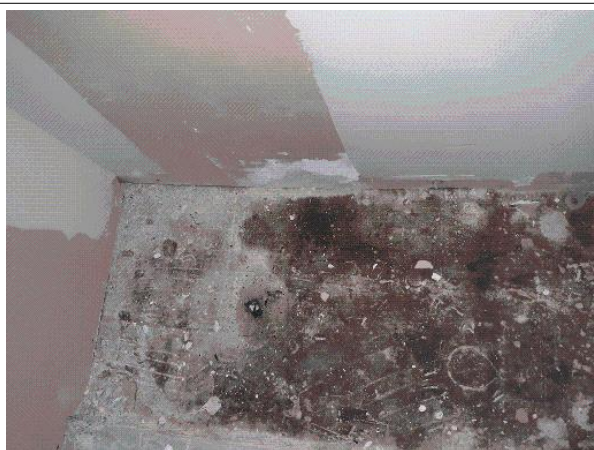
Prélèvement - P065 : R+1 / Zone Désaffectée / Espace distribution auto - Revêtement bitumineux- (Absence d'amiante)
