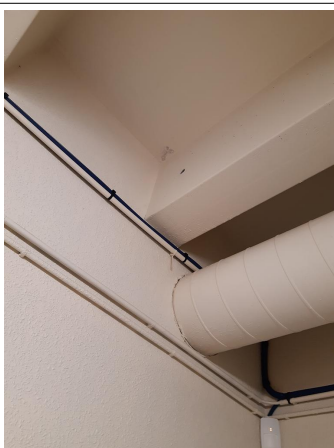
Prélèvement - P090 : R+1 / Zone cuisine / Réserves 2 - Enduit- (Présence d'amiante)
