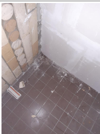
Prélèvement - P053 : R+1 / Zone Désaffectée / Espace co-working - Colle- (Absence d'amiante)
