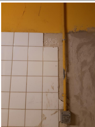
Prélèvement - P079 : R-1 / Zone stockage 2 - Colle- (Absence d'amiante)
