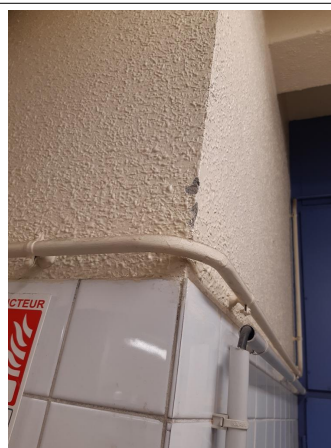
Prélèvement - P020 : R+1 / Zone cuisine / Laverie vaisselle et plonge - Enduit- (Présence d'amiante)
