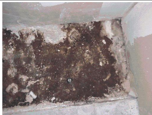
Prélèvement - P064 : R+1 / Zone Désaffectée / Espace distribution auto - Revêtement bitumineux- (Absence d'amiante)
