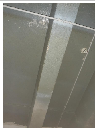
Prélèvement - P068 : R+1 / Zone Désaffectée / Espace distribution auto - Enduit- (Présence d'amiante)
