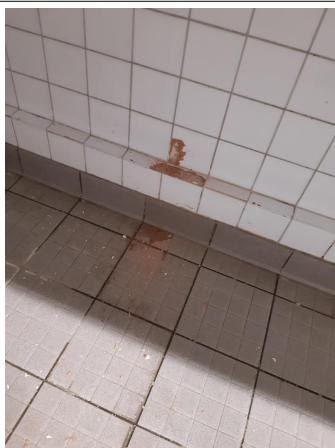
Prélèvement - P025 : R+1 / Zone cuisine / Réserve / Coin cuisine - Colle- (Absence d'amiante)
