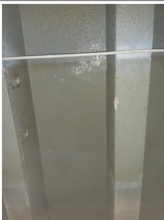
Prélèvement - P069 : R+1 / Zone Désaffectée / Espace distribution auto - Enduit- (Présence d'amiante)
