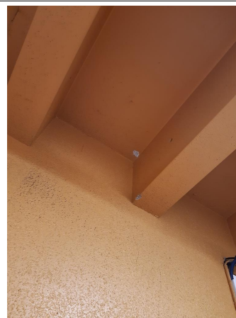
Prélèvement - P089 : R+1 / Zone cuisine / Bureau - Enduit- (Présence d'amiante)
