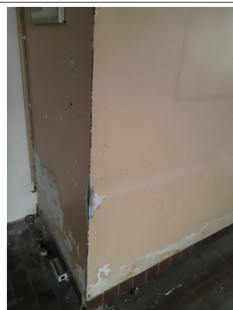
Prélèvement - P060 : R+1 / Zone Désaffectée / Espace co-working - Enduit- (Absence d'amiante)
