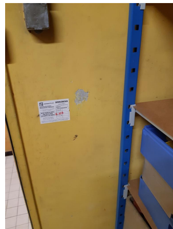
Prélèvement - P085 : R-1 / Zone stockage 3 - Enduit- (Présence d'amiante)
