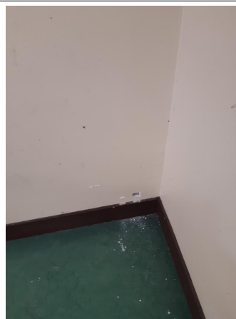
Prélèvement - P011 : R+1 / Zone Accueil et salle restaurant - Enduit- (Absence d'amiante)
