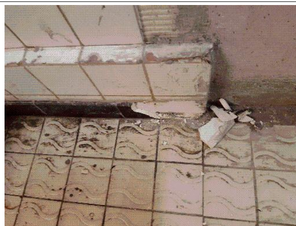
Prélèvement - P078 : R-1 / Couloir - Colle- (Présence d'amiante)
