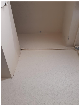
Prélèvement - P086 : R+1 / Zone cuisine / Laverie vaisselle et plonge - Enduit- (Absence d'amiante)
