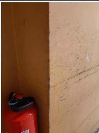
Prélèvement - P075 : R-1 / Couloir - Enduit- (Présence d'amiante)
