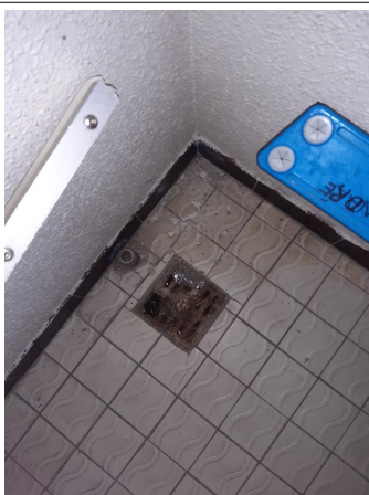
Prélèvement - P015 : R+1 / Zone cuisine / Local déchets tampon et Dégagement - Colle- (Absence d'amiante)
