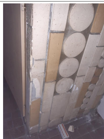
Prélèvement - P062 : R+1 / Zone Désaffectée / Espace co-working - Colle- (Absence d'amiante)
