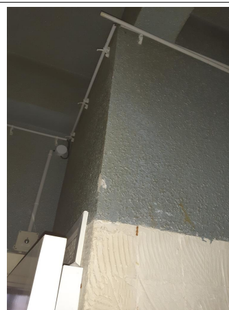
Prélèvement - P066 : R+1 / Zone Désaffectée / Espace distribution auto - Enduit- (Présence d'amiante)
