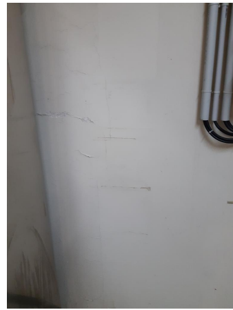
Prélèvement - P083 : R-1 / Zone stockage 1 - Enduit- (Absence d'amiante)
