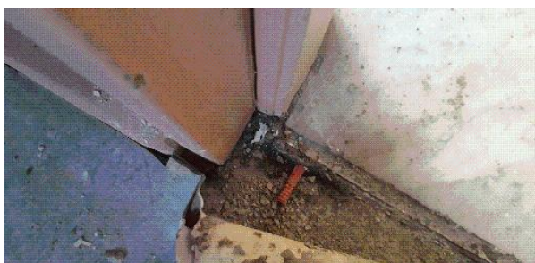
Prélèvement - P050 : R+1 / Bureau - Ragréage- (Absence d'amiante)
