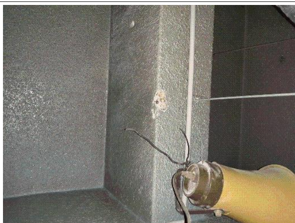
prélevé - idem P069 : R+1 / Zone cuisine / Local Préparation froid - Enduit- (Présence d'amiante)
