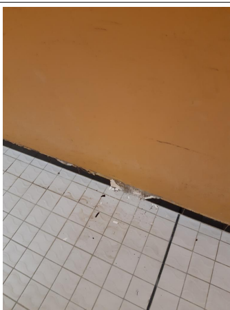
Prélèvement - P077 : R-1 / Couloir - Colle- (Absence d'amiante)
