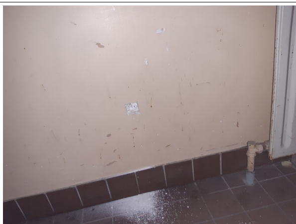
Prélèvement - P061 : R+1 / Zone Désaffectée / Espace co-working - Panneau de cloison- (Absence d'amiante)
