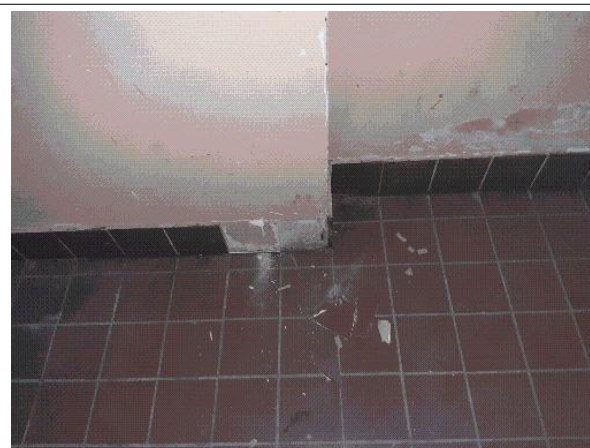
Prélèvement - P056 : R+1 / Zone Désaffectée / Espace co-working - Colle- (Absence d'amiante)
