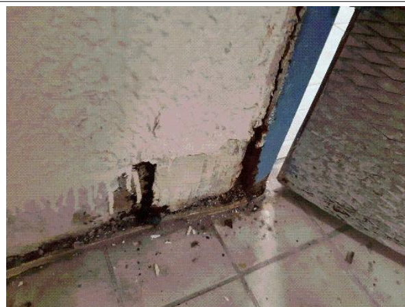
Prélèvement - P028 : R+1 / Zone cuisine / Réserves 2 - Colle- (Présence d'amiante)
