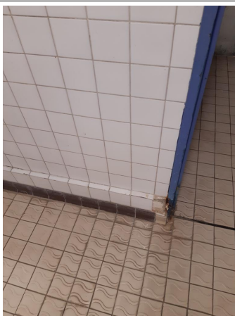
Prélèvement - P017 : R+1 / Zone cuisine / Laverie vaisselle et plonge - Colle- (Absence d'amiante)
