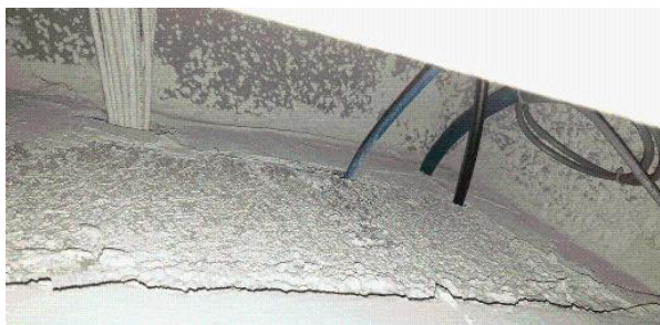
Prélèvement - P092 : R+1 / Bureau - Enduit projeté- (Absence d'amiante)
